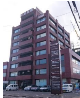
訓練実施施設の外観
