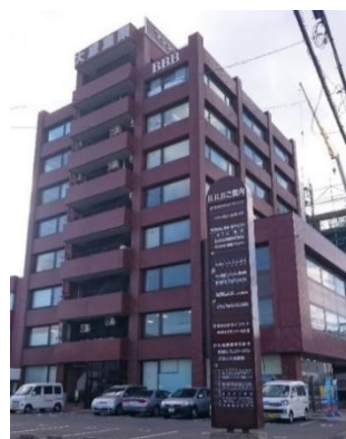
訓練実施施設の外観
