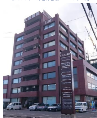
訓練実施施設の外観
