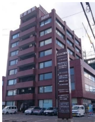
訓練実施施設の外観
