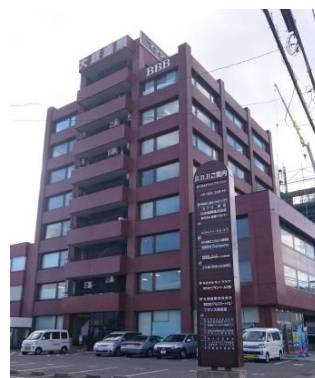
訓練実施施設の外観
