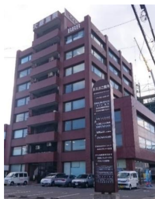
訓練実施施設の外観
